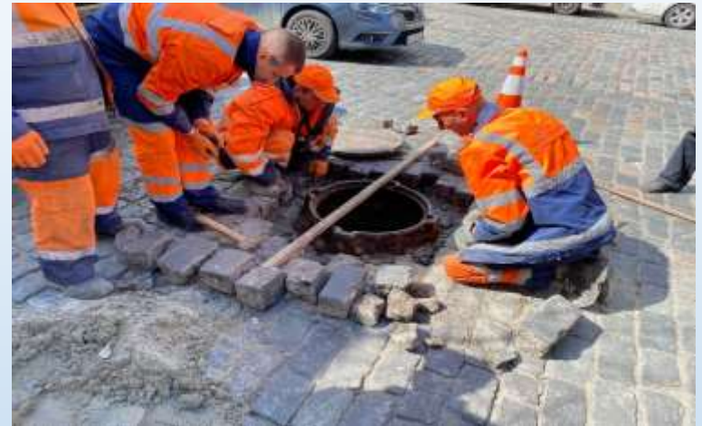
Ремонт оглядових колодязів по вулиці Великій Васильківській
