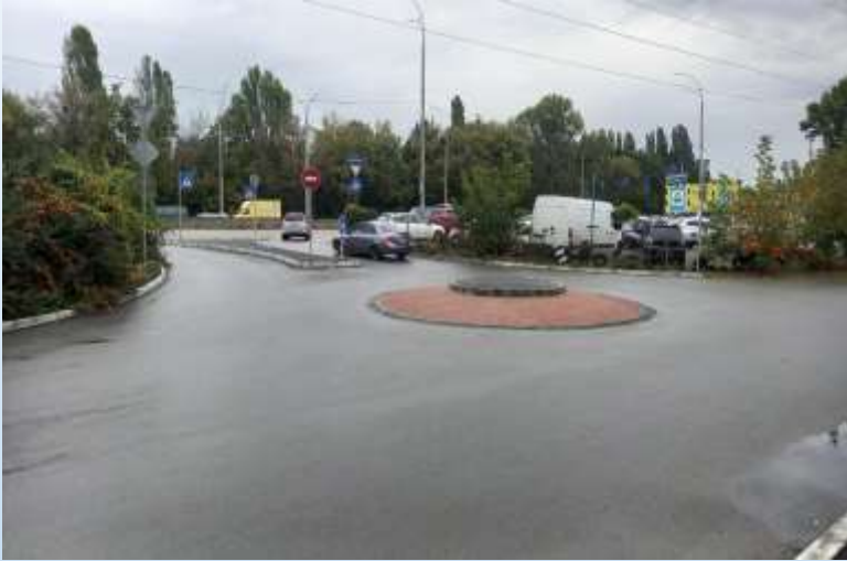
Влаштування кільцевої розв'язки малого радіуса вулиця Академіка Заболотного, 92
