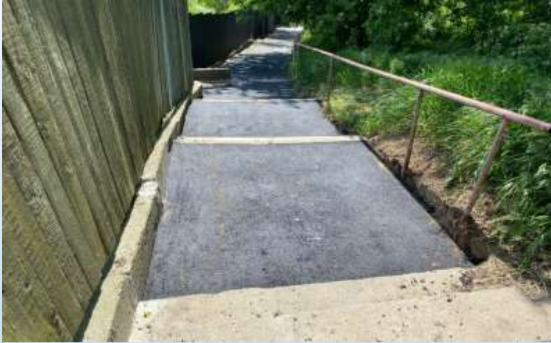
Ремонт сходів вулиця Квітки-Основ'яненка
