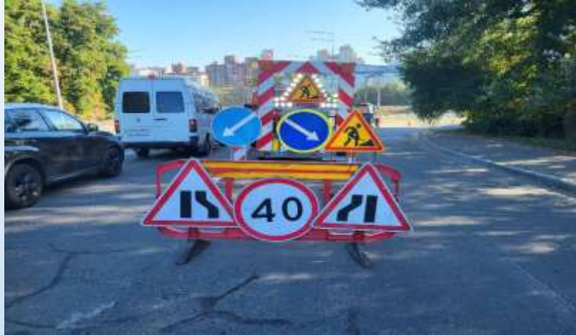
Заливка тріщин установкою установкою Крафко вулиці Володимира Брожка
