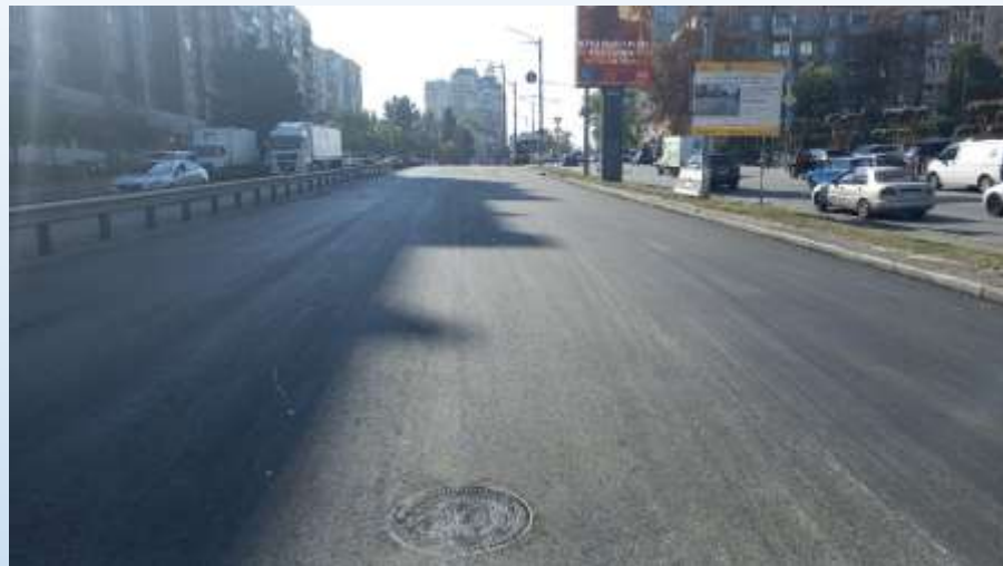
Поточний ремонт проспект Голосіївський
