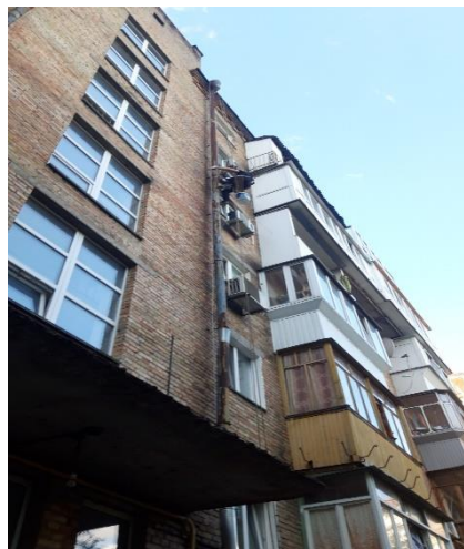
вул. Васильківська, 15/14 (ремонт водостічних труб)
