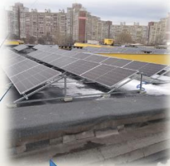
Встановлення автономного джерела електроенергії ЗЗСО №286 вул. Залізнична Академіка, 6 А
