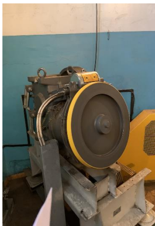
вул. Голосіївська, 10 (заміна гальмівного пристрою)
