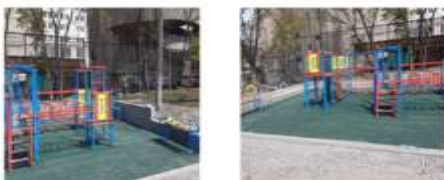
Реалізований проєкт № 667 «Спортивно-ігровий майданчик у школі 112» Виконавець – Управління будівництва
