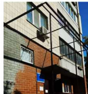
Ремонт із встановлення захисного екрану вхідної групи дитячо-юнацького клубу «Романтик» (вул. Тарасівська, 36-А)
